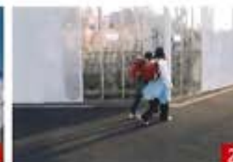
出隅部透明仮囲い設置例
