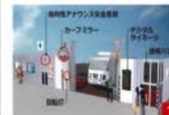
工事用ゲート設置イメージ
